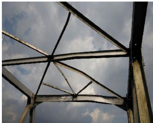
Gambar 2. Kegagalan pada Ikatan Angin Karena Benturan
