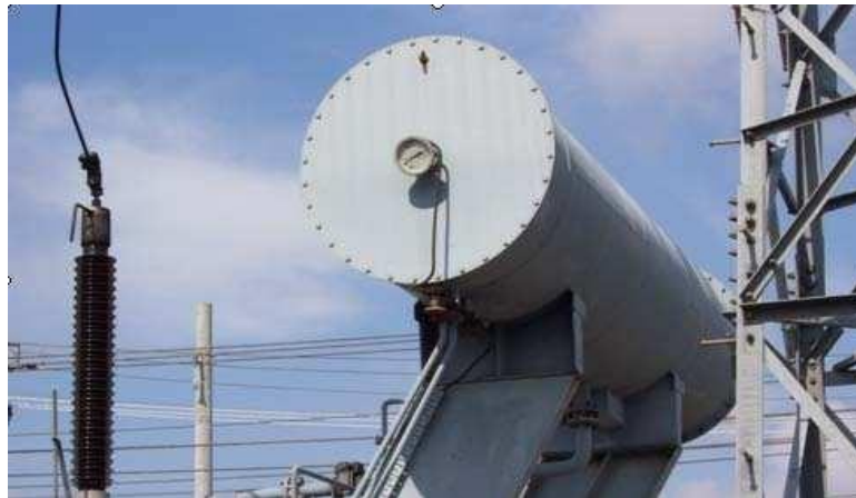
Gambar 2.13 Konservator Minyak Transformator
