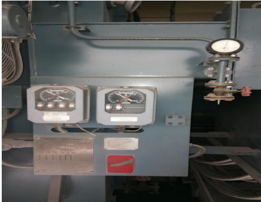
Gambar 2.16 Indikator Level Minyak dan Temperature
